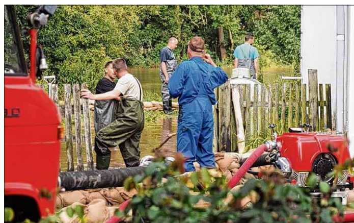
Pumpen, Sandsäcke verbauen, kontrollieren – diese Arbeiten liefen an der Hoppenstedter Mühle die ganze Nacht zum Donnerstag.
