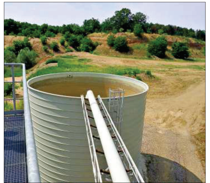
Diesen riesigen Wasserbehälter gab es früher nicht. Im Zuge der neu installierten Aufbereitungsanlage wird jetzt das dafür benötigte Wasser in einem Kreislauf wiederverwendet.
